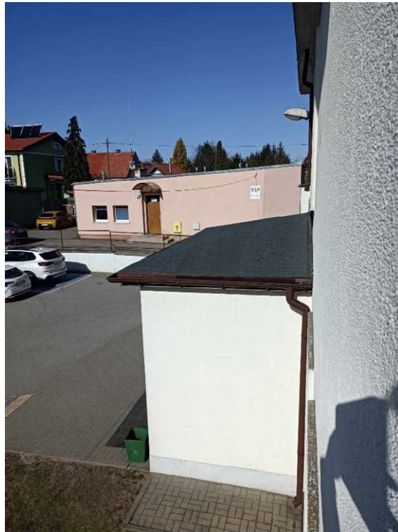
Rys. 8 Widok dachu cd.
