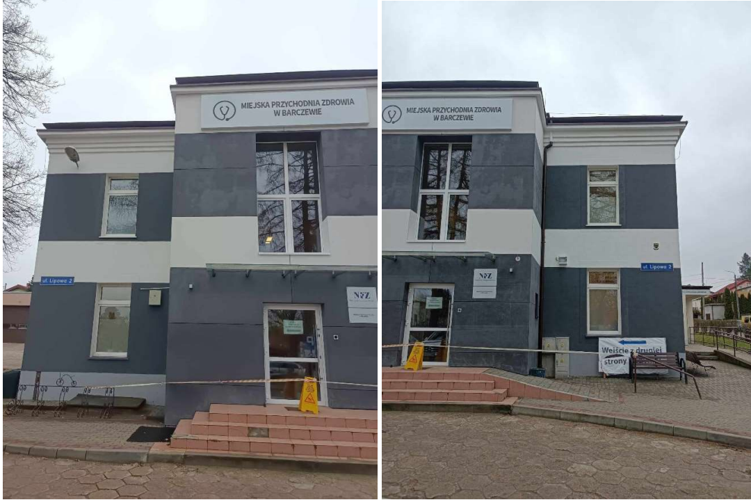
Rys. 1 Elewacja frontowa, od strony ulicy
